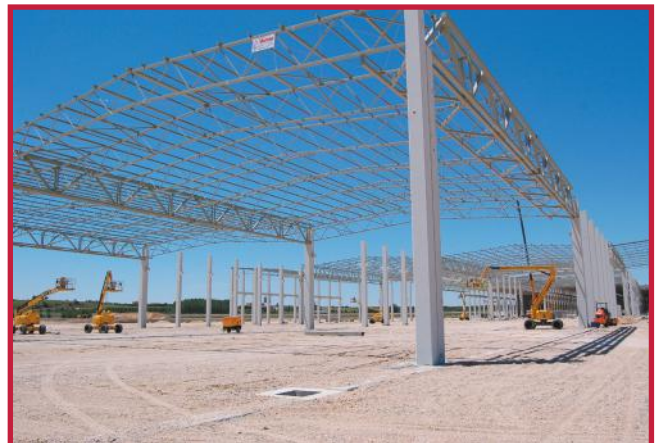
Nave de fabricación de aerogeneradores en Burgos
