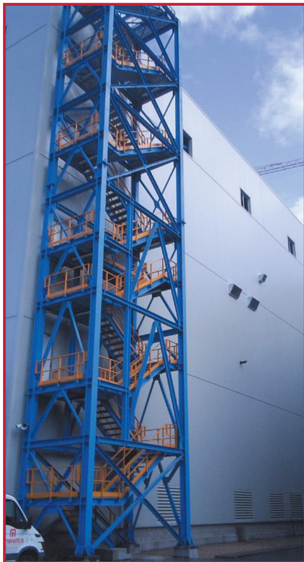
Planta térmica de Ciclo Combinado en Zaragoza
